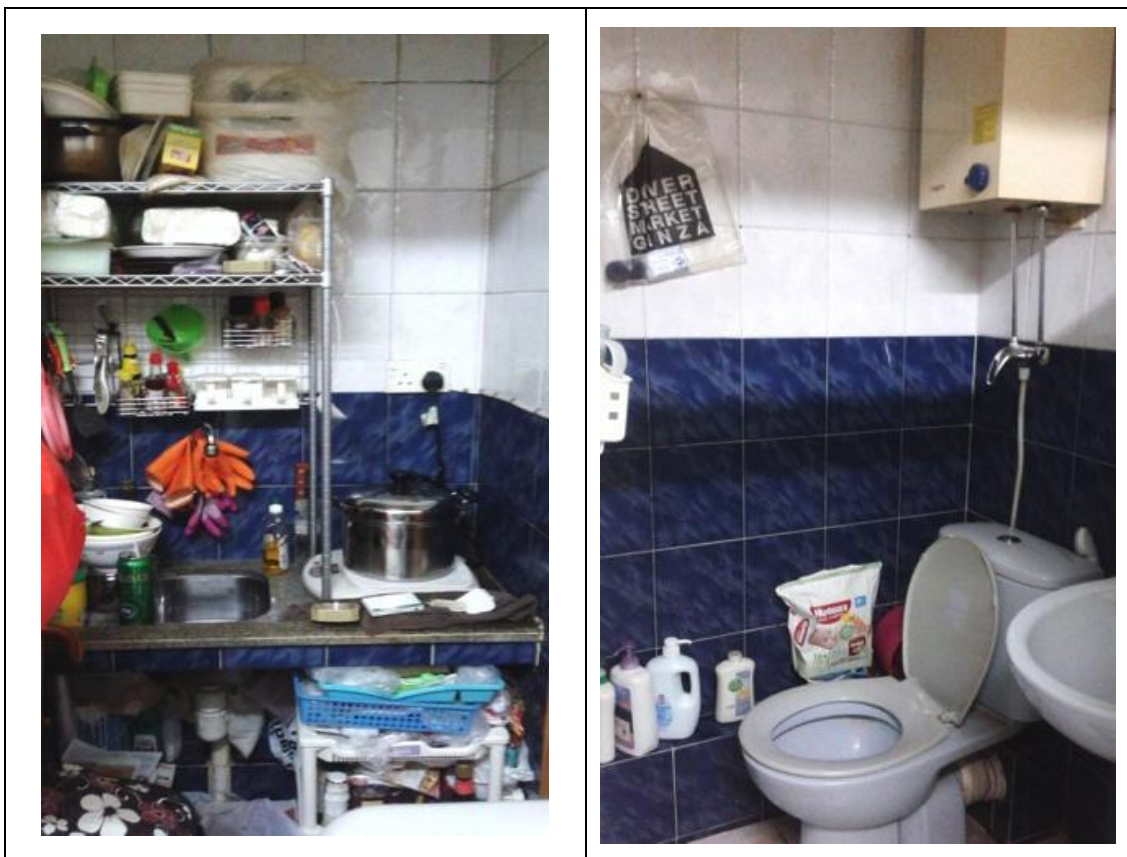
圖三：港島區劏房室內情況
